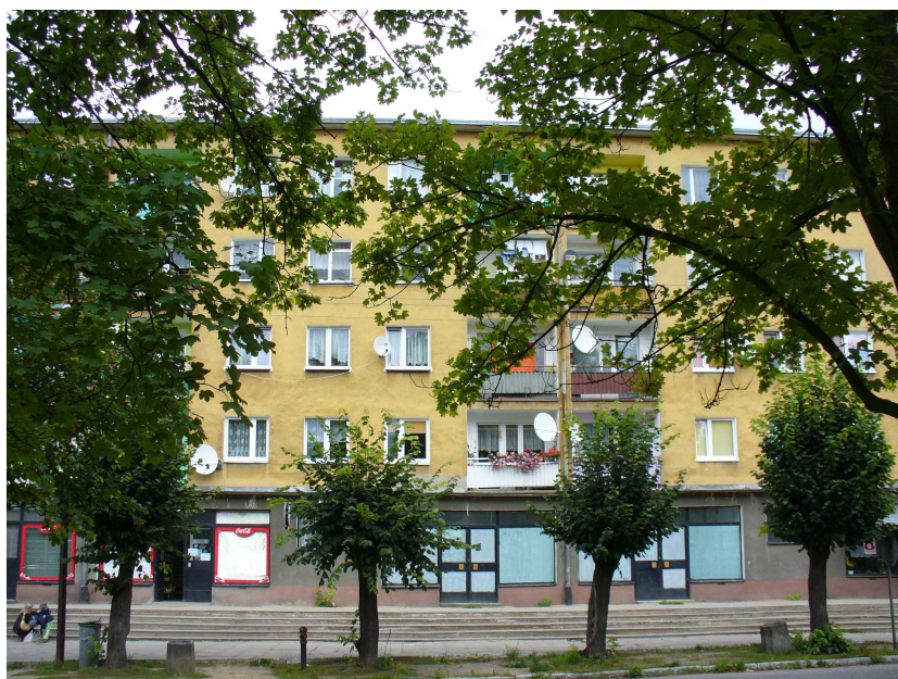
ul. Grunwaldzka 38 a, b, c - modernizacja i ocieplenie elewacji oraz przebudowa usługowego parteru wielorodzinnego budynku mieszkalno-usługowego, renowacja schodów zewnętrznych.
