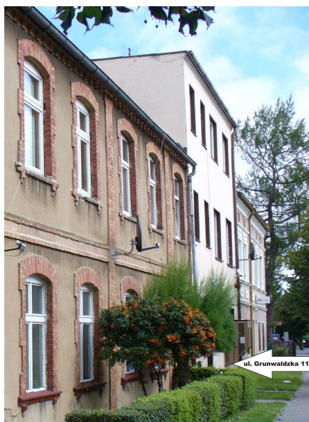
ul. Grunwaldzka 11 – modernizacja i termoizolacja elewacji historycznego budynku, przebudowanego i pozbawionego detalu architektonicznego elewacji.
